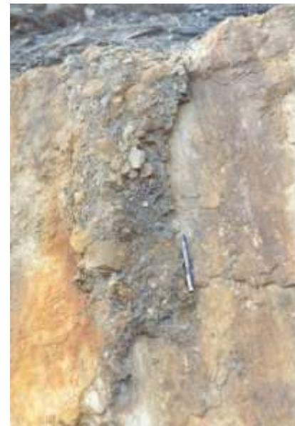
Brèche de faille
